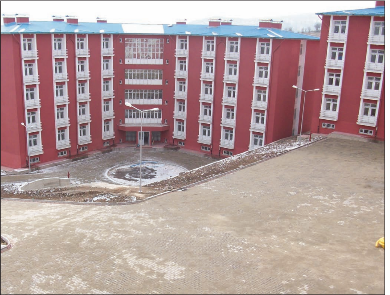
Polis Okulu İnşaatı
