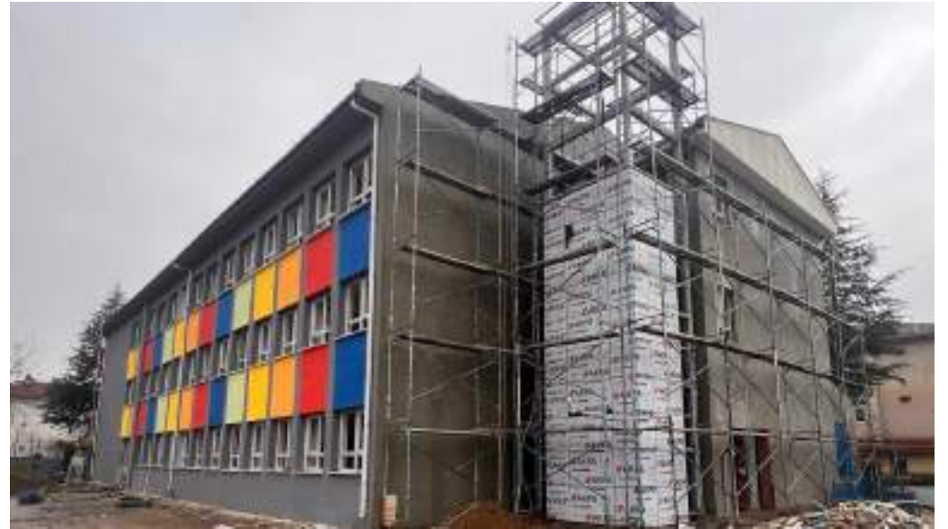
TAŞKÖPRÜ BAHRİ ALP ORTAOKULU GÜÇLENDİRME ve ONARIMI
