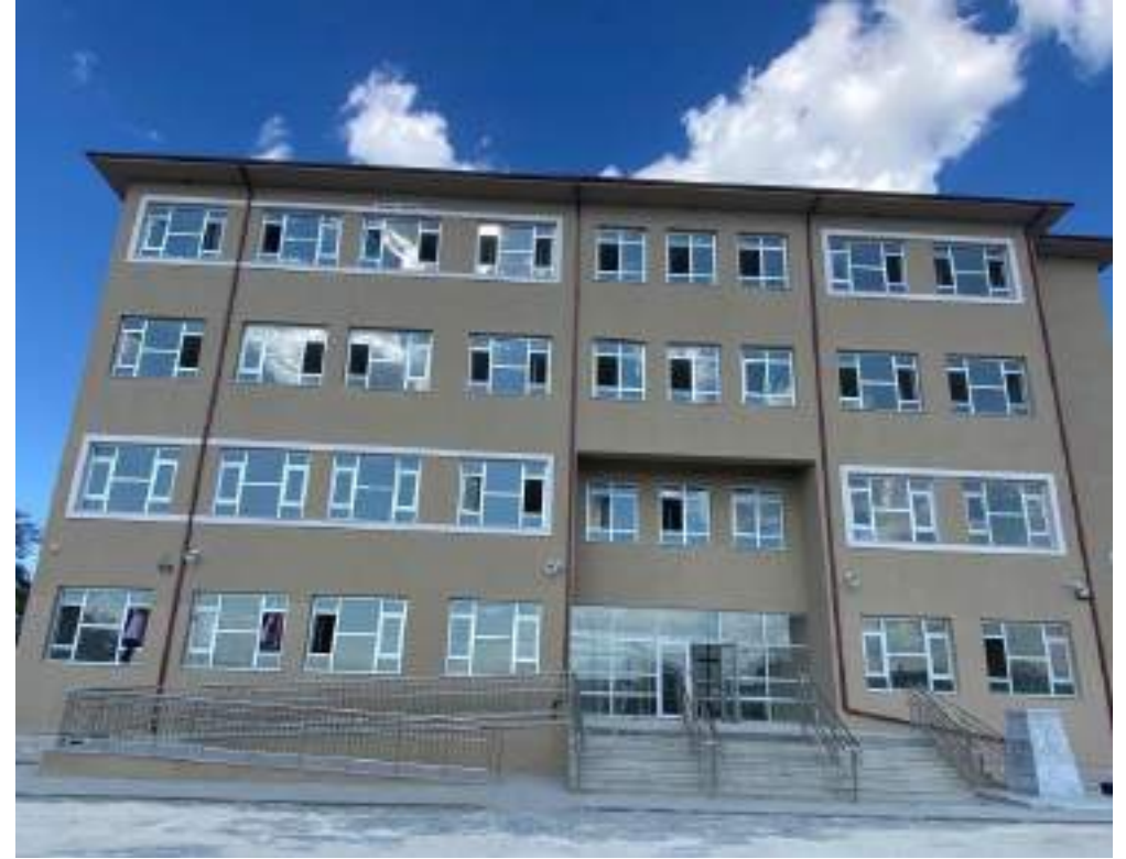
TAŞKÖPRÜ 12 DERSLİKLİ İLKOKULU YAPIMI
