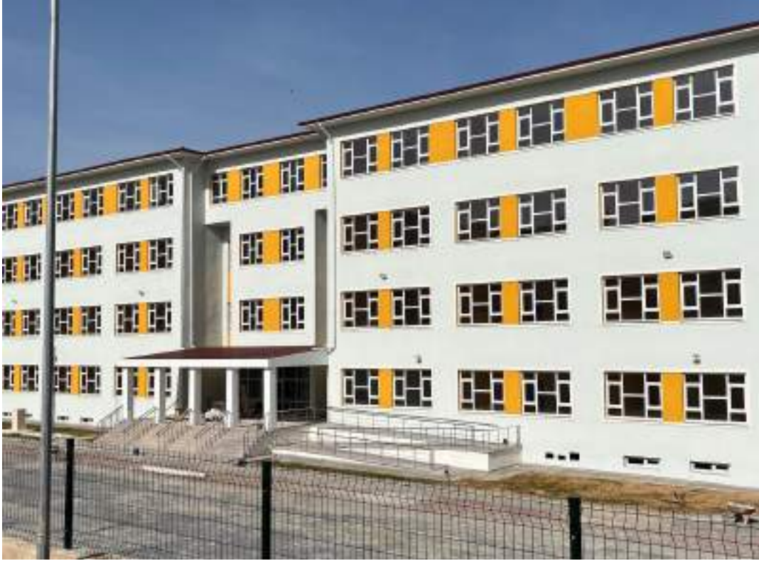
MERKEZ HACIBEY 24 DERSLİKLİ ORTAOKULU YAPIMI
