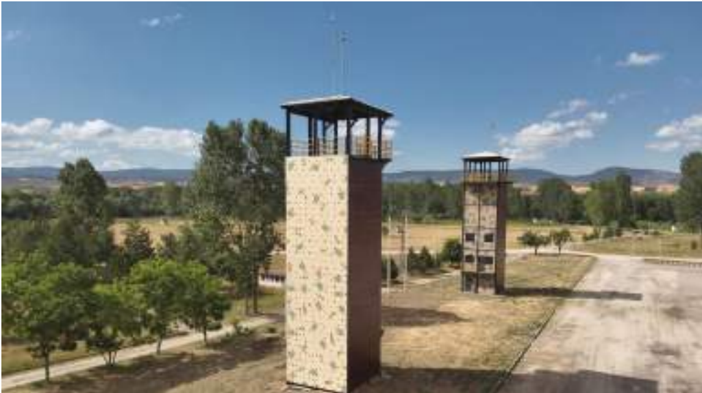
JANDARMA EĞİTİM MERKEZİ KOMUTANLIĞI ÇOK MAKSATLI KULE İNŞAATI ( 2 adet kule) Yapımı
