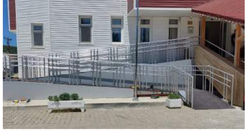
POLİSEVİ ENGELLİ RAMPASI ve MERDİVEN DÜZENLEMESİ ONARIMI
