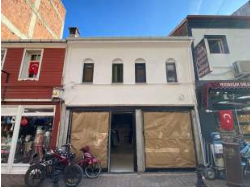
İnebolu, Aşağıhatıpbacı Mahallesi, 422 Ada 21 Parseldeki Tescilli Taşınmaz
