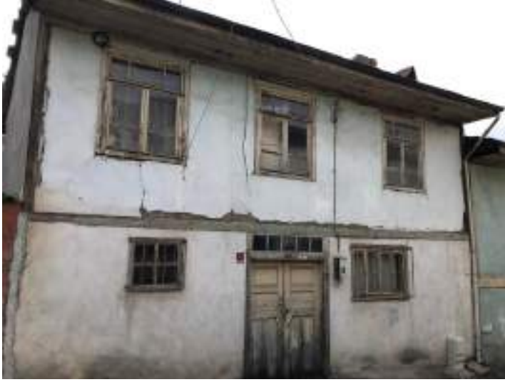
Tosya, Mimar Sinan Mahallesi, 212 Ada 2 Parseldeki Taşınmaz
