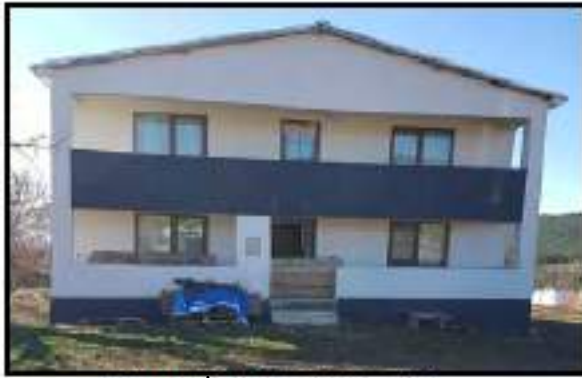
Araç İlçesi Karakaya Köyü 119 ada 108 parsele ait aykırı yapı
