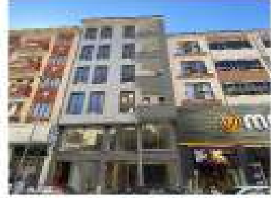
KASTAMONU İLİ TAŞKÖPRÜ İLÇESİ ÇAMKÖYER MAHALLESİ/ 126 ADA 18 PARSELDE BULUNAN TİCCUL SİZ TAŞINMAZ AYI 26.08.2022 TARİHLİ FOTOĞRAFLAR
