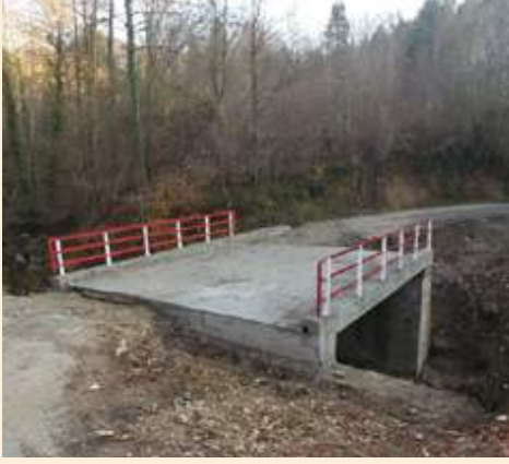
İnebolu Alaca Köyü Köprü Yapım İşi
