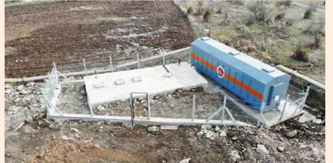
Doğa Spor Kompleksi Kanalizasyon İşİ Fosseptik ve Biyolojik Arıtma
