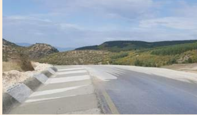
Taşköprü Köçekli Beton Hendek Çalışması
