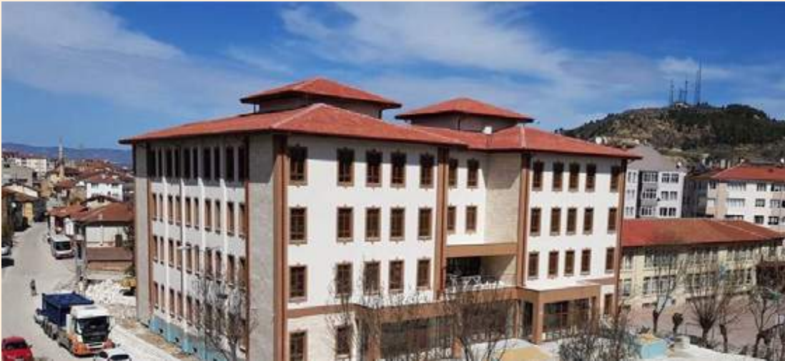
Kastamonu Aile ve Sosyal Politikalar İl Müdürlüğü ve Sosyal Hizmet Merkezi Müdürlüğü Binası Yapım İşİ
