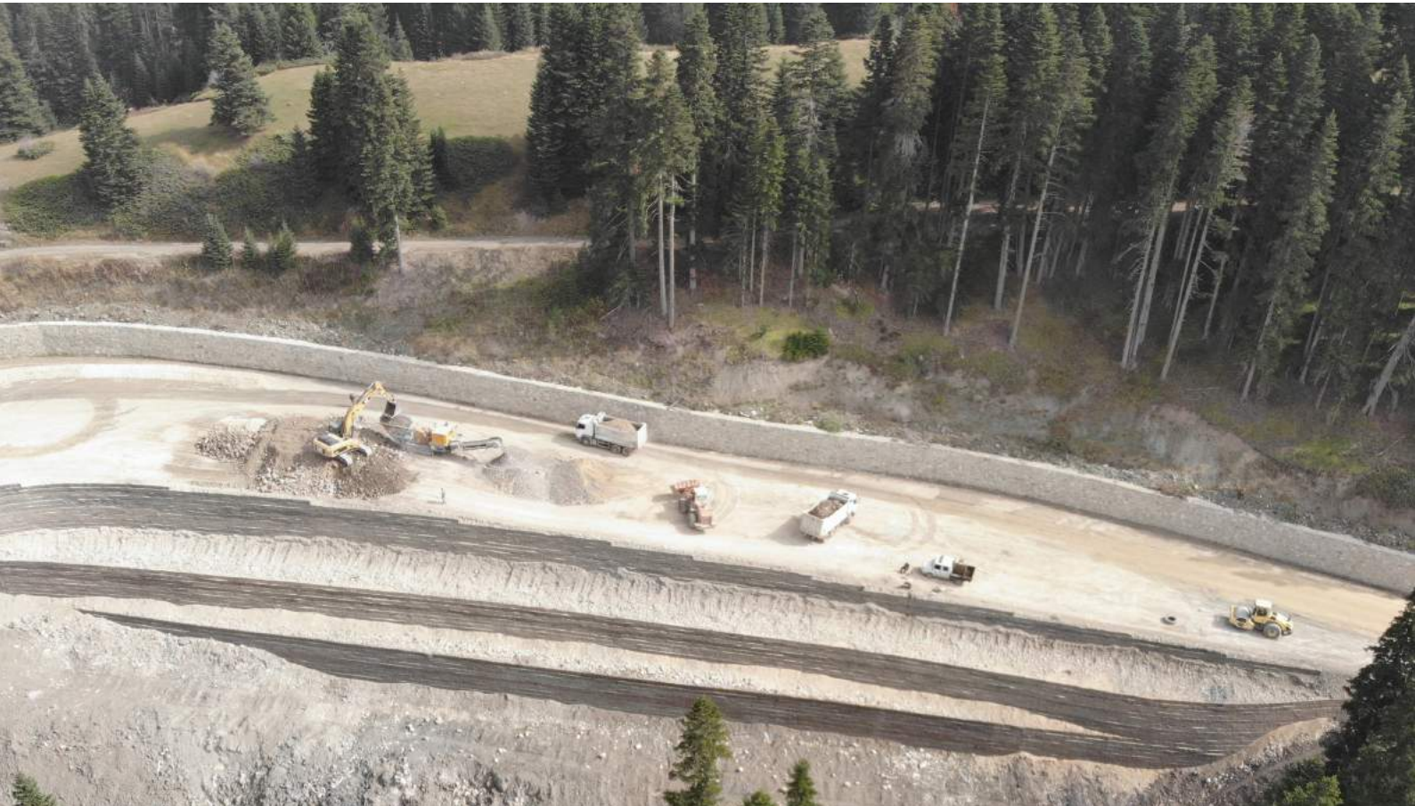
Ilgaz Yurduntepe Turizm Yolu - Geo Sentetik Donatılı Duvar - Uzunluk: 110 mt Yükseklik:13 mt.
