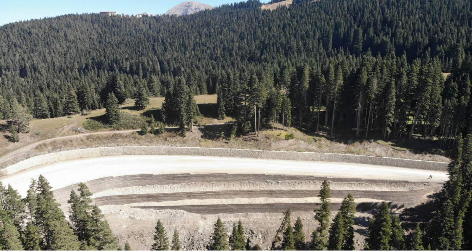
Ilgaz Yurduntepe Turizm Yolu - Geo Sentetik Donatılı Duvar - Uzunluk: 110 mt Yükseklik:13 mt.
