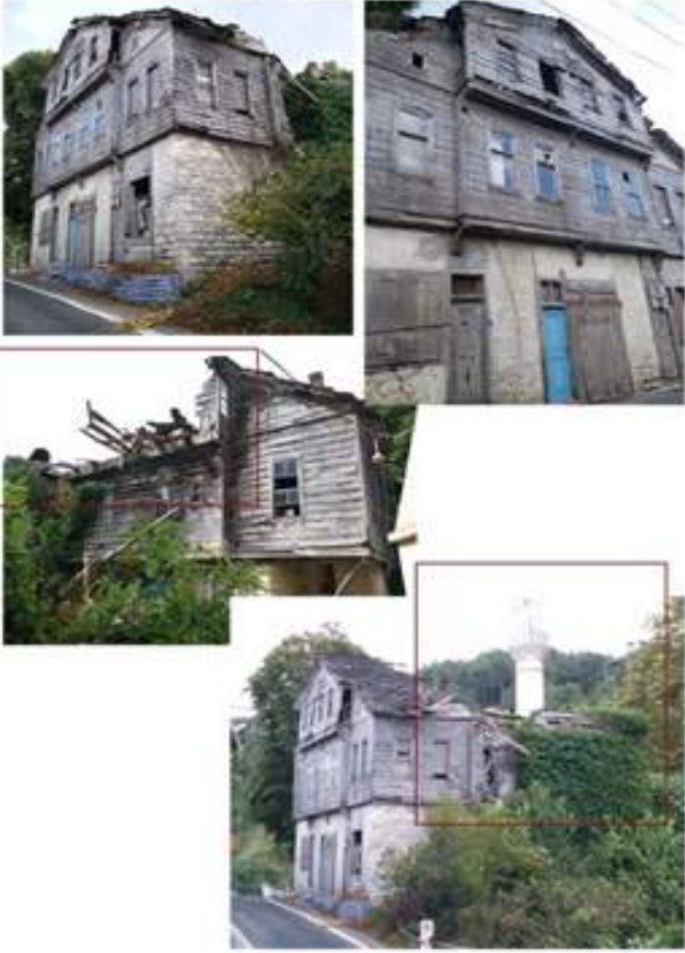
KASTAMONU İLİ, ARANA İLÇESİ, HACİVELİ MAHALLESİ 245 ADA 2 PARSELDE BULUNAN TESCİLLİ TAŞINMAZA AIT 06.09.2018 TARİHLİ FOTOĞRAFLAR
