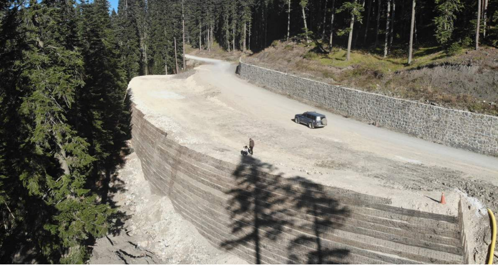
Ilgaz Yurduntepe Turizm Yolu - Geo Sentetik Donatılı Duvar - Uzunluk: 110 mt Yükseklik:12 mt.
