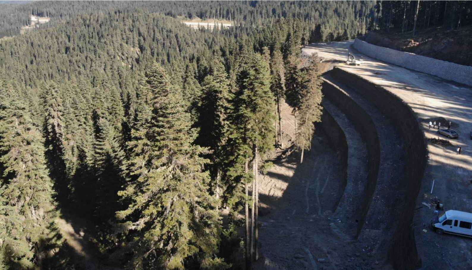
Ilgaz Yurduntepe Turizm Yolu - Geo Sentetik Donatılı Duvar - Uzunluk: 200 mt Yükseklik:25 mt.
