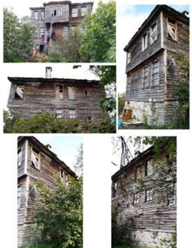
KASTAMONU İLİ, İNEBOLU İLÇESİ, KARADENİZ MAHALLESİ, 147 ADA 2 PARSELDE BULUNAN TESCİLLİ TAŞINMAZA AIT 15.10.2018 TARİHLİ FOTOĞRAFLAR
