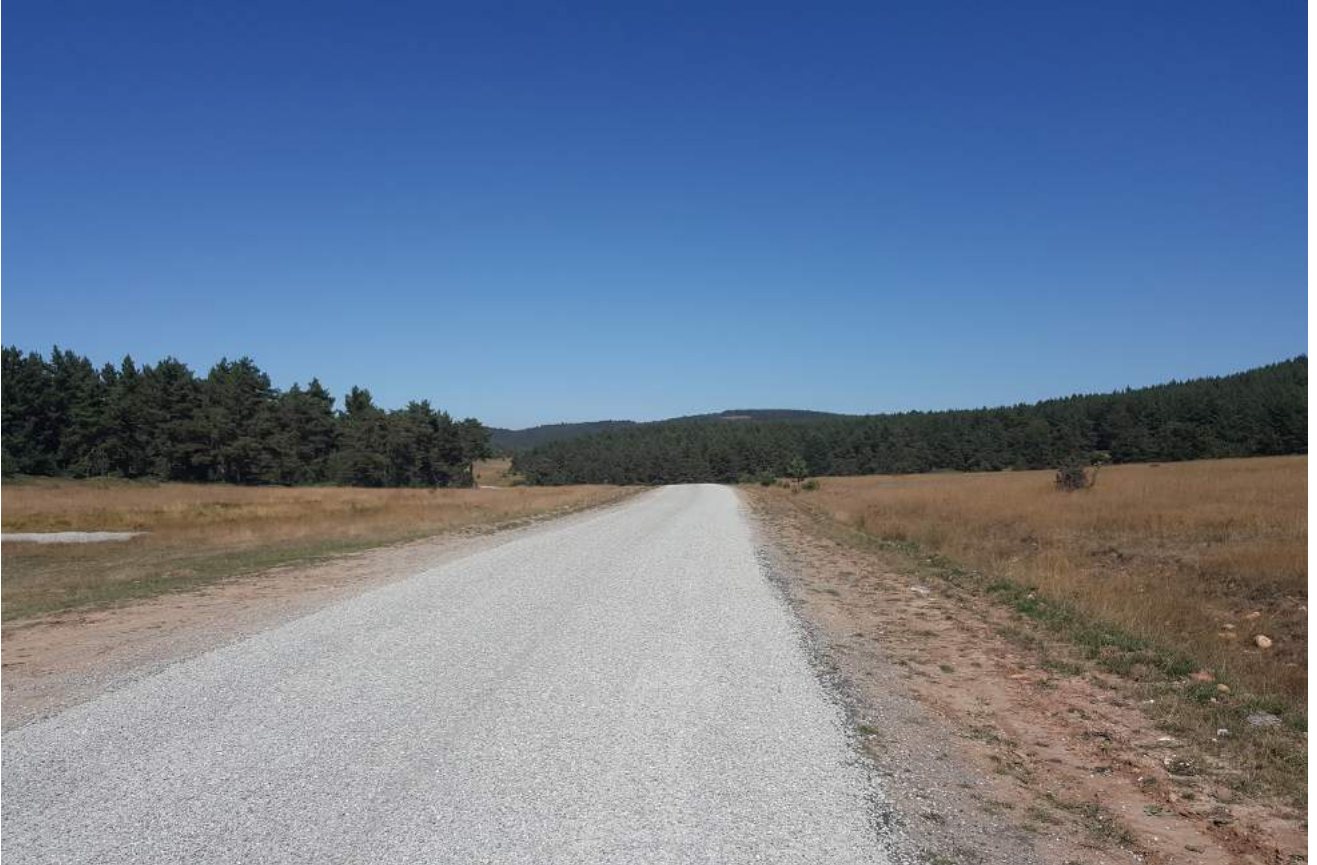
Tosya Kilkuyu 2. Kat Asfalt Çalışması
