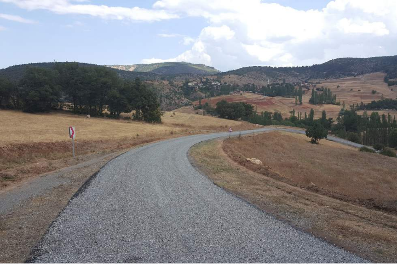
Tosya Kızılcaçukur 2. Kat Asfalt Çalışması
