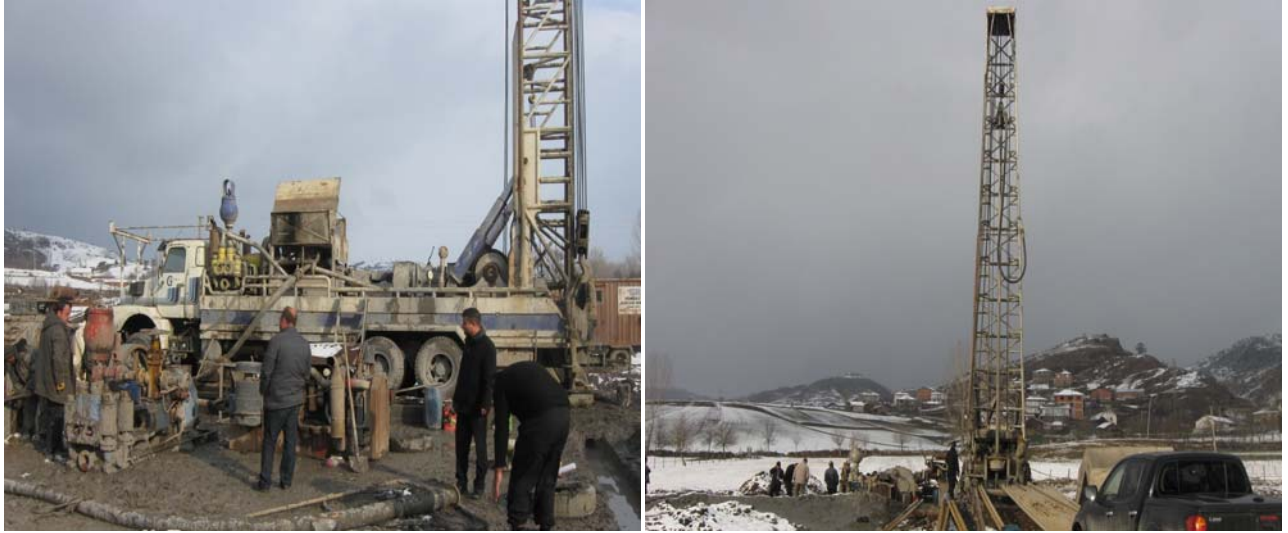
Ağlı ilçesi Jeotermal Kaynak arama sondajı
